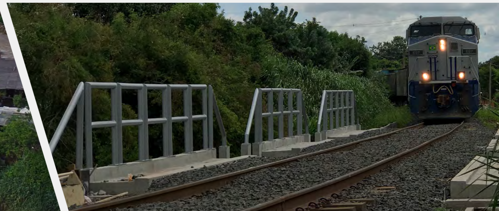
OBRA DE SUSTITUIÇÃO DE PONTILHÕES FERROVIÁRIOS Substituição de pontilhões ferroviários vazados por pontilhões em concreto armado e lastreado através da utilização de guindastes rodoviários.
